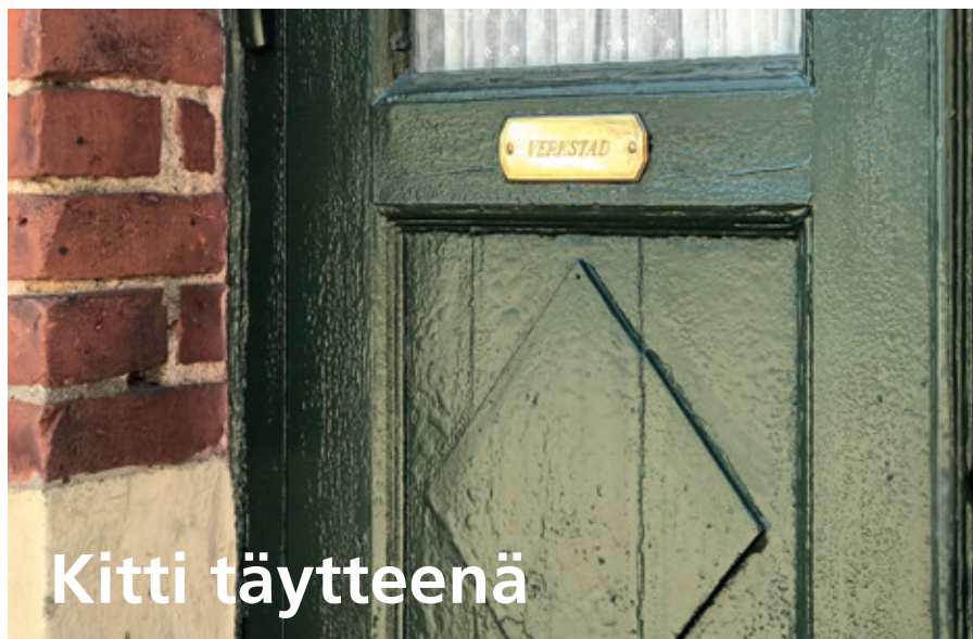
Ovi vuodelta 1926. Yksinkertainen "ikäääntymisen viivyttämistoimenpide" sadaksi vuodeksi. Pellavaöljykitti halkeamiin. Maalaus suoraan uudella pellavaöljymaalilla vanhentuneelle pinnalle.
