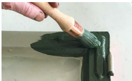
Levitä maalauspinnalle paksu ja tasainen maalikerros. Yhden maalikerroksen tulee muodostaa valoa läpäisemätön pinta..
