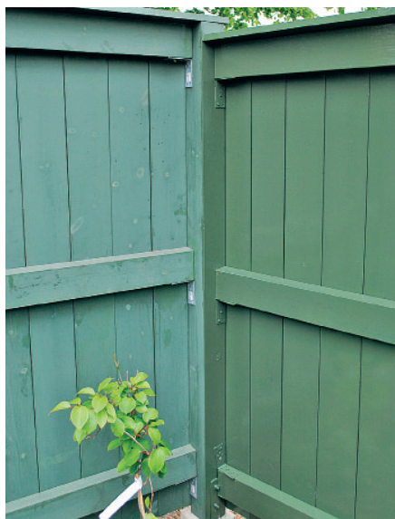
Ensimmäinen ja toinen maalikerros. Kolme kerrosta riittää useimmille pinnoille.
