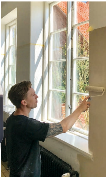
Maalaa ja tasoita Linus mattamaalilla lankatelaa tai sivellintä käyttäen.
